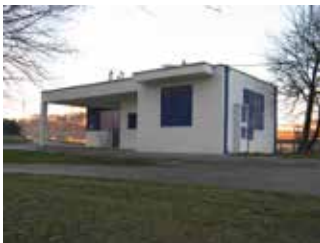
Obr. č. 87: Budova Propeleru
