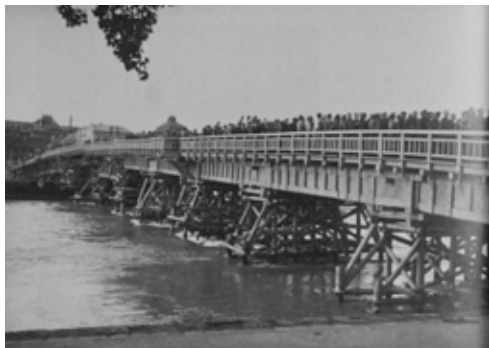
Obr. č. 57: Oproti kaviarni Leberfinger vybudovala Červená armáda drevený most
